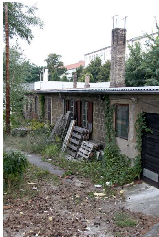
Baracke 13 vor Beginn der Restaurierungsarbeiten © Dokumentationszentrum NS-Zwangsarbeit
